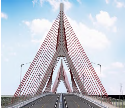
Figura 15. Imagen del atirantamiento visto desde la calzada.
