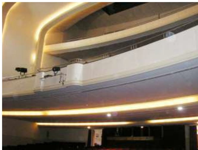
Figura 4. Vista de los entrepisos del teatro.
