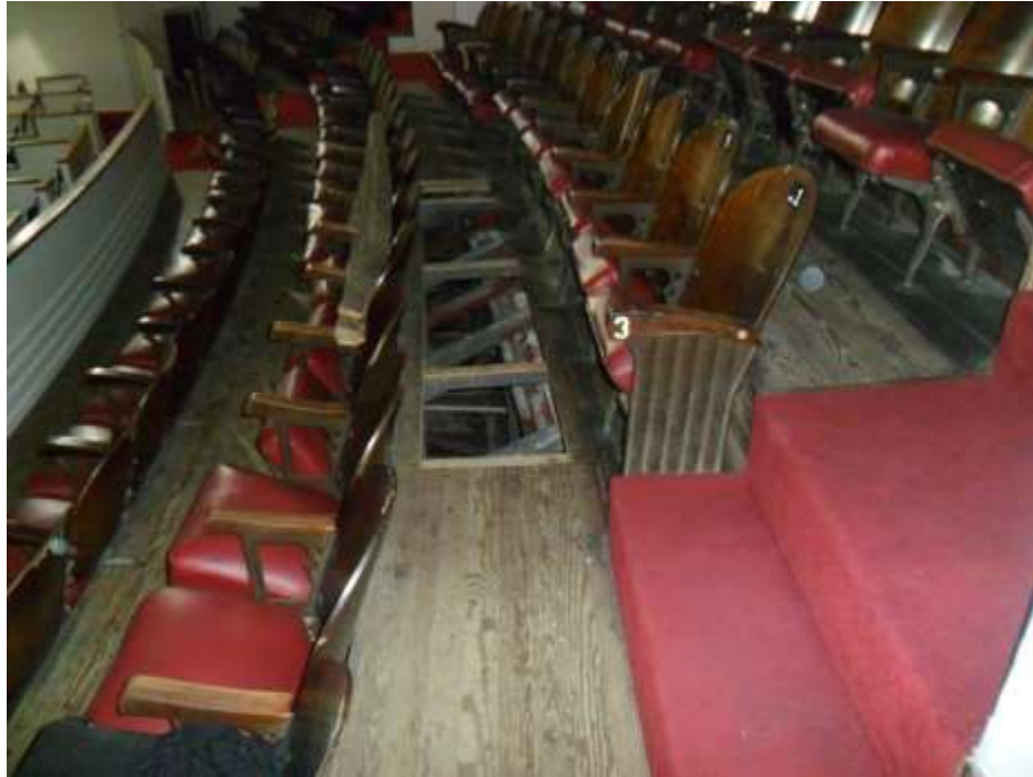
Figura 13. Vista de la viga transversal entre las butacas del teatro.
