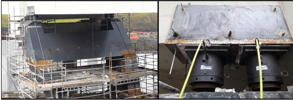
Figura 20. Dovela 4 con gatos de Fase 1 instalados
