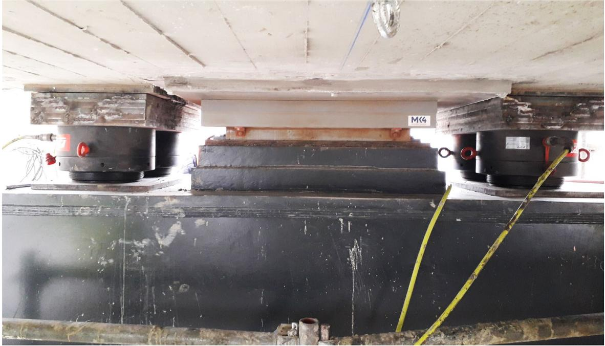
Figura 29. Gatos y aparato de apoyo para la Fase de transferencia 2.2
