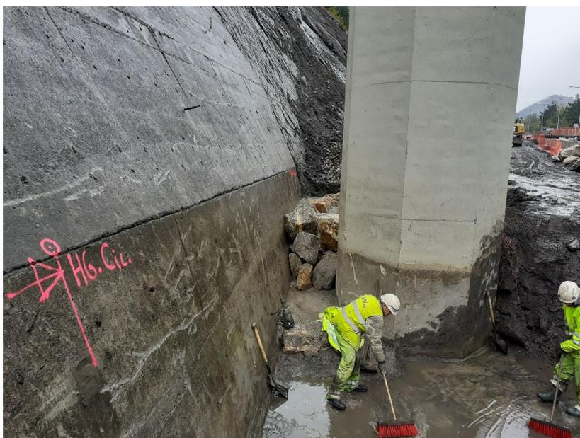
Figura 14. Excavación y limpieza para ejecución de la cimentación
