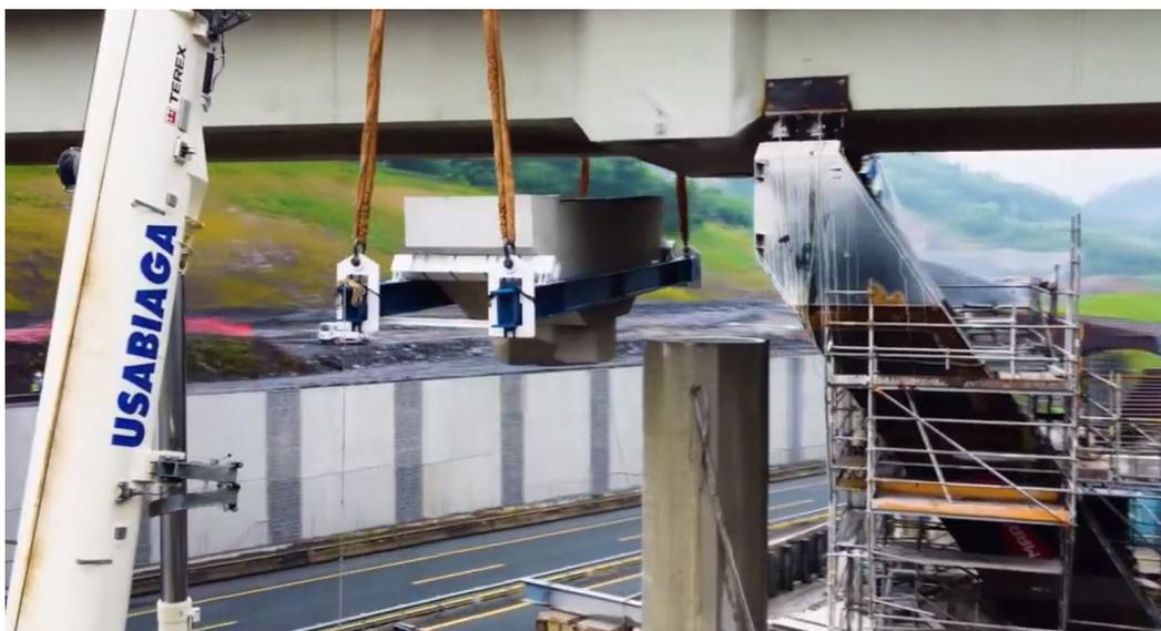
Figura 24. Retirada del dintel de la pila original
