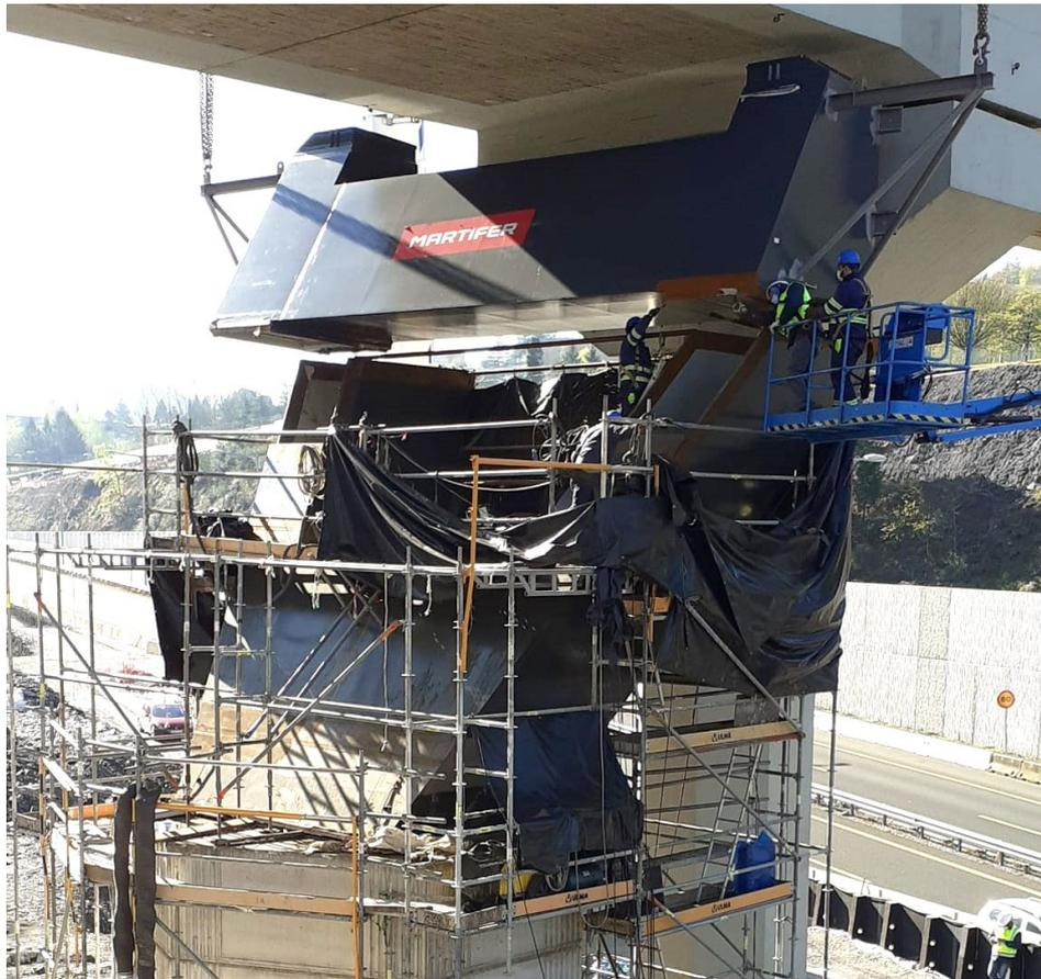
Figura 19. Montaje de dovela 4.
