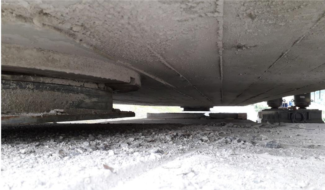
Figura 23. Aparatos de apoyo originales colgando del tablero.
