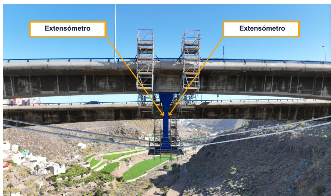
Figura 35. Posición de los extensómetros destinados a medir la deformación del puntal metálico durante el proceso de tesado del atirantamiento.
