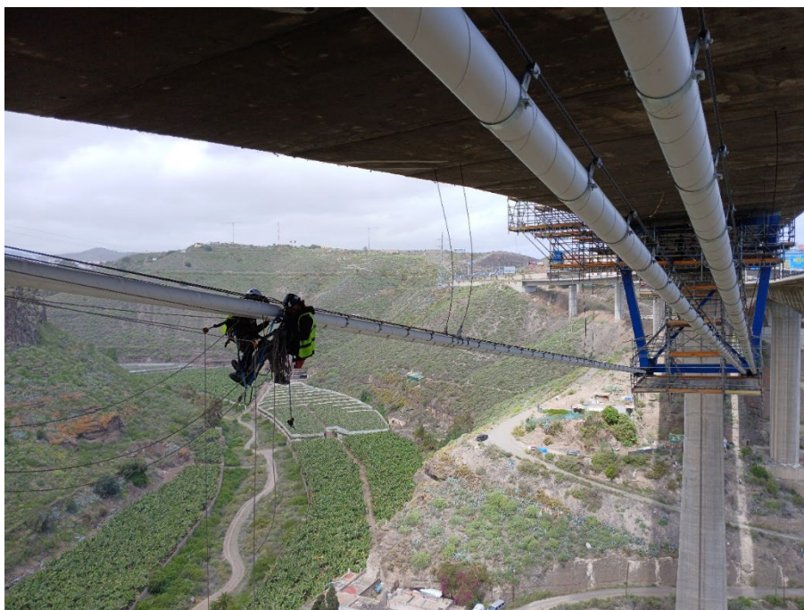
Figura 34. Trabajo de especialistas, para desmontaje de elementos de soporte provisional de los tendones de atirantamiento
