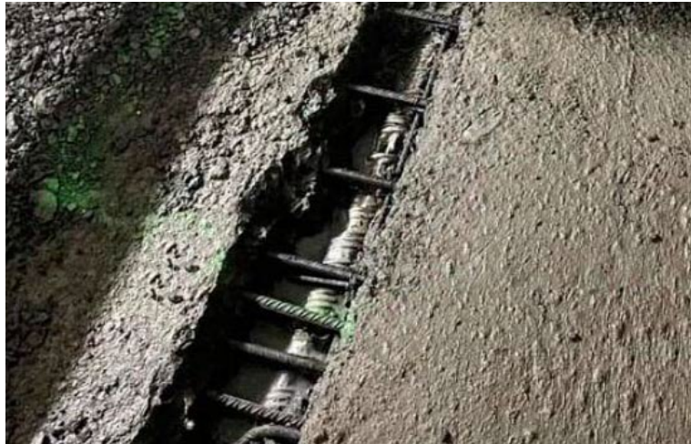
Figura 7. Apertura de una zanja longitudinal en el hormigón, realizada con hidrodemolición, para inspeccionar el estado de un tendón existente en la losa inferior del tablero
