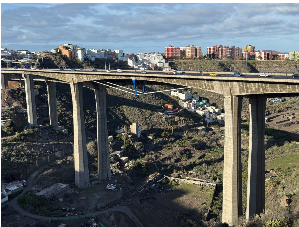
Figura 37. Viaducto del Guinguada. Aspecto final, tras la culminación de la obra de rehabilitación y refuerzo
