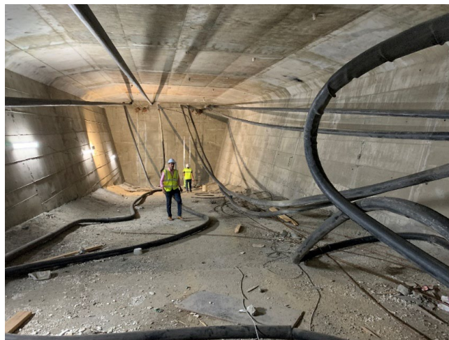
Figura 5. Interior del tablero de la Estructura E-15, situada aguas abajo del Barranco de Guinguada
