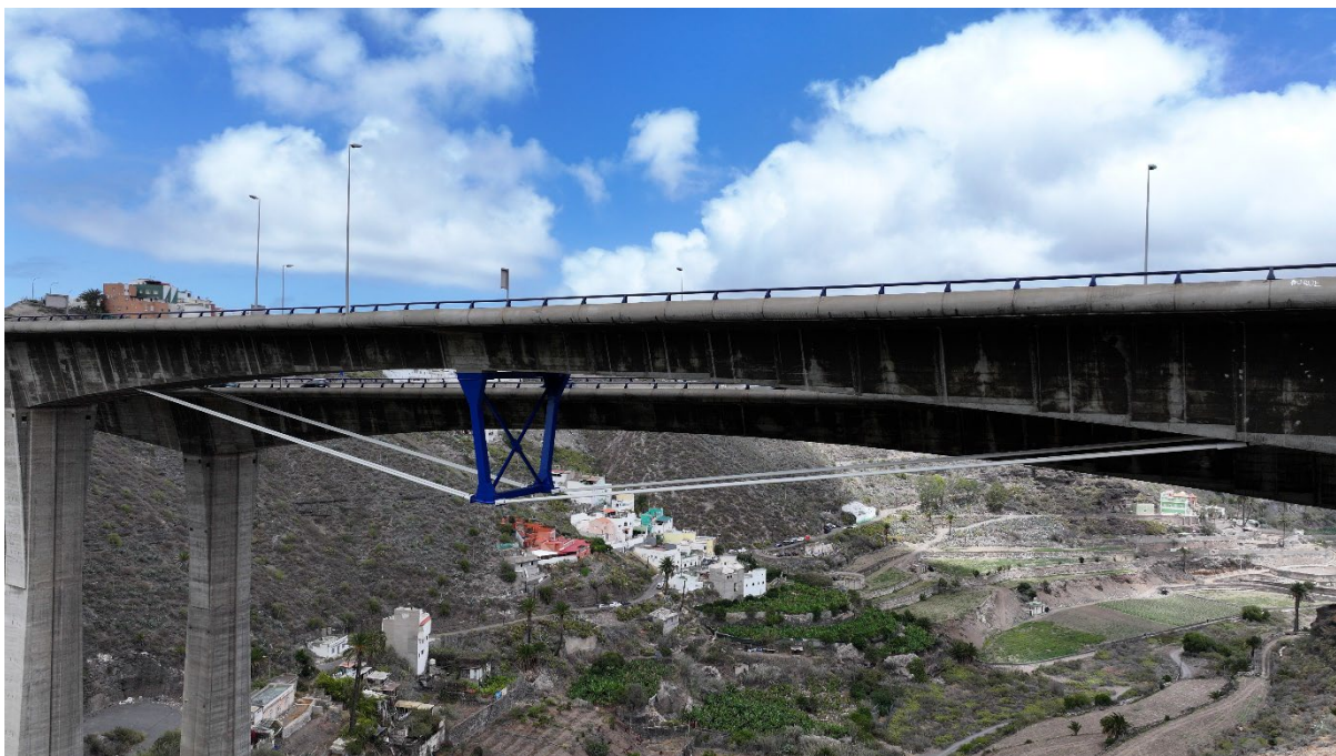
Figura 19. Vista general del atirantamiento inferior del tablero
