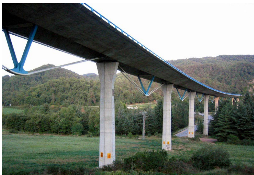
Figura 17. Viaducto de Osormort, perteneciente al Eje Transversal Gerona – Lérida.
