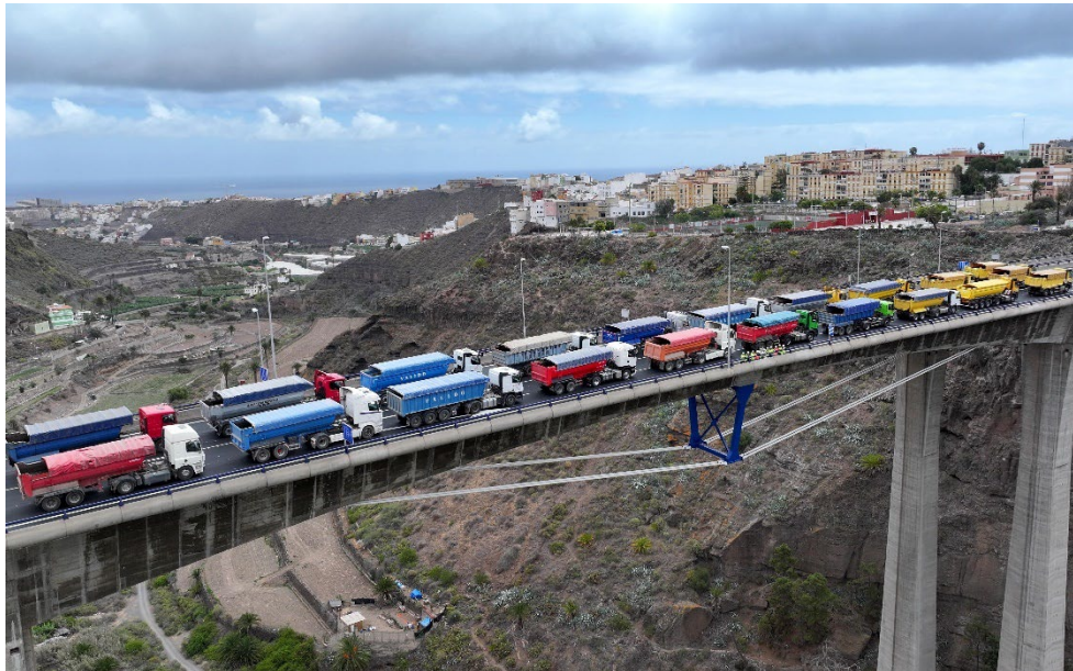
Figura 36. Prueba de carga del viaducto con los camiones situados en el vano provisto de atirantamiento inferior del tablero
