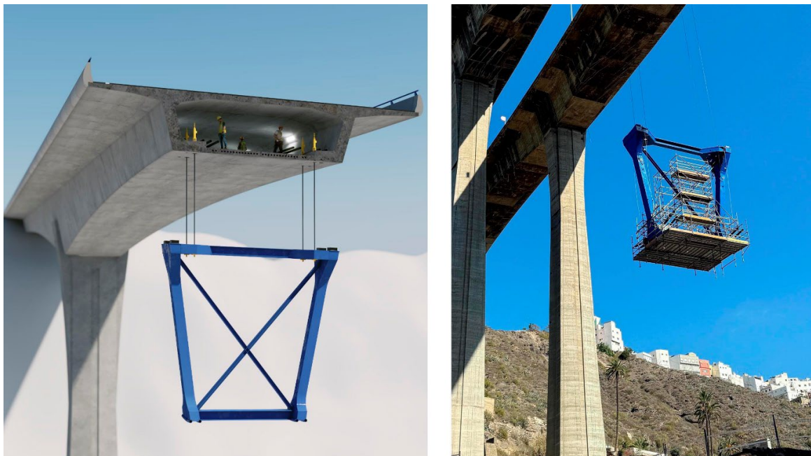
Figura 27. Izado del puntal metálico desviador. Esquema, con la disposición de gatos “heavy lifting” en el interior del tablero e imagen real de la maniobra efectuada
