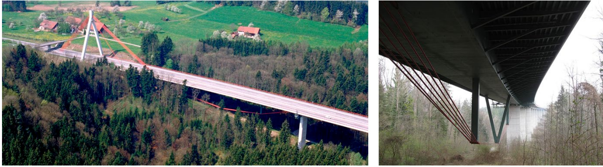
Figura 15. Viaducto Obere Argen (Alemania)
