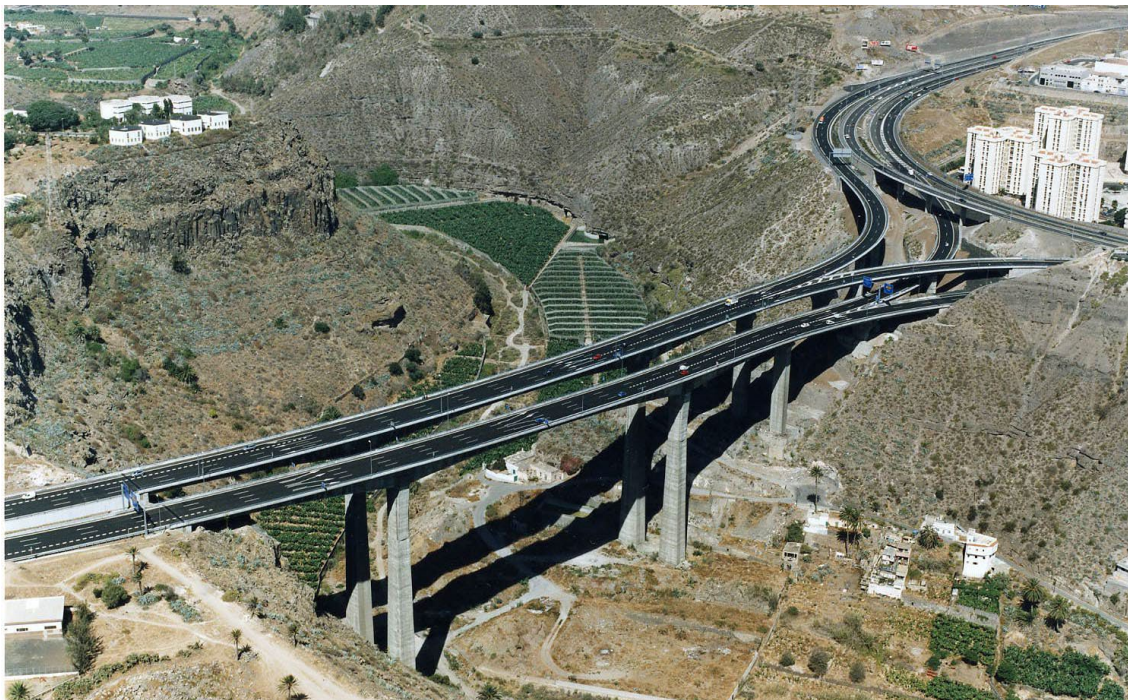
Figura 1. Viaducto del Guinguada. Vista aérea
