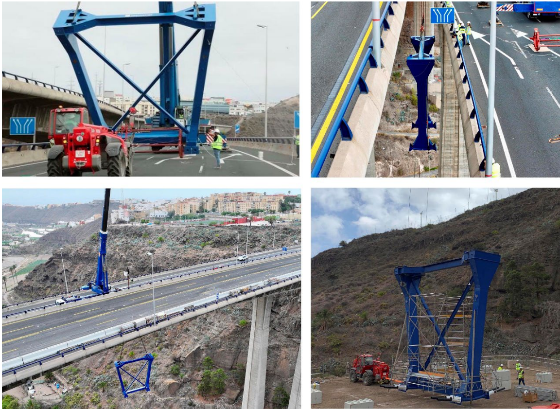
Figura 26. Imágenes varias de la operación de descenso y colocación del puntal metálico en el fondo del barranco
