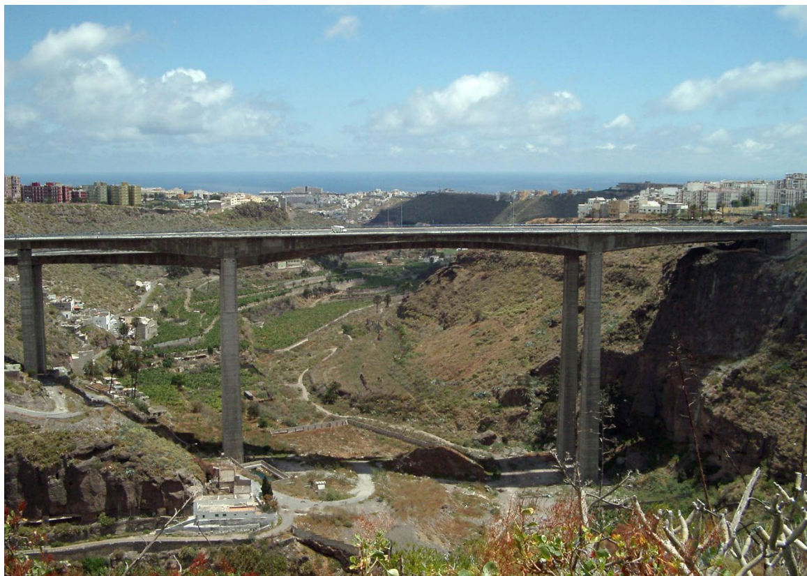
Figura 2. Vista general del tramo del viaducto construido por avance en voladizo
