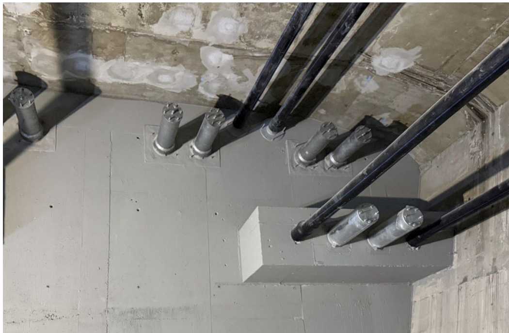
Figura 23. “Capots” metálicos de protección de anclajes, situados en el mamparo existente en la zona de tablero situada sobre las pilas principales
