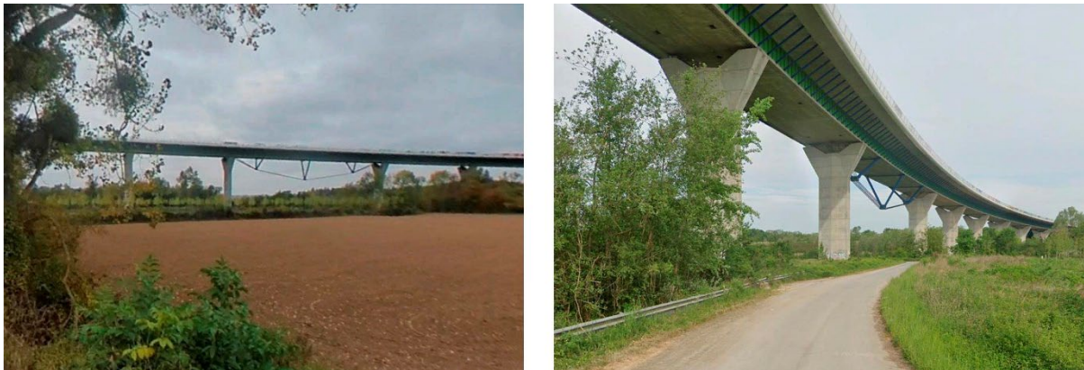
Figura 14 Viaducto sobre el Marne, en Meaux (Francia)
