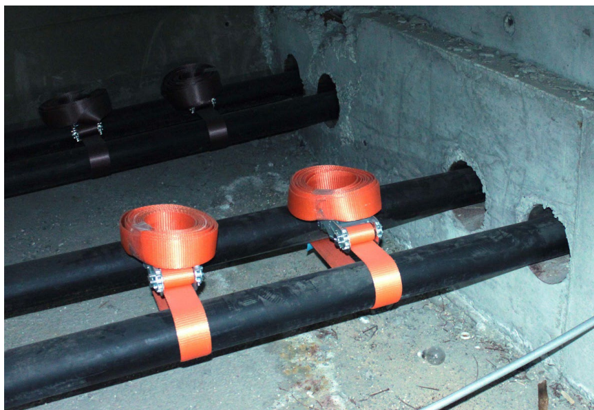
Figura 8. Eslingado de tendones
