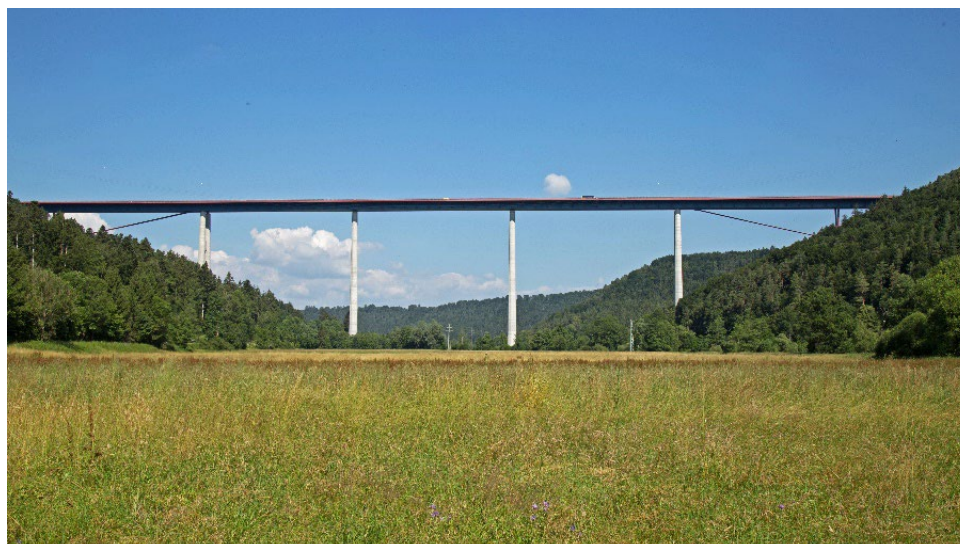
Figura 12. Vista general del Viaducto Neckar. Weitingen (Alemania)
