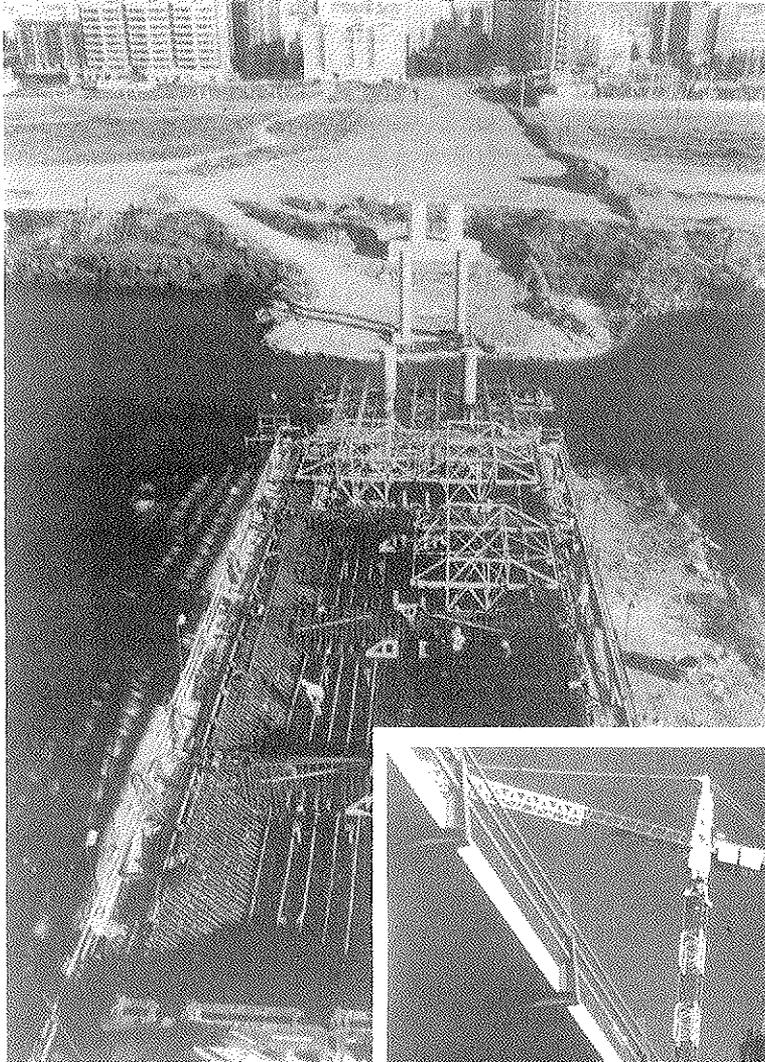
Figura 5. Montaje de ferralla y encofrados interiores.
