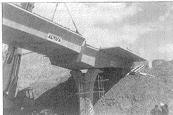
Foto 4. Detalle durante el montaje del tramo central.
