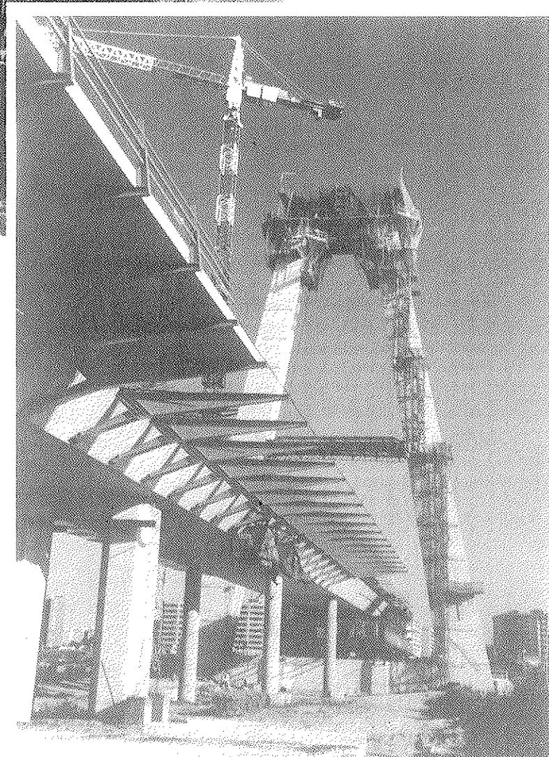
Figura 6. Montaje del primer elemento de la célula metálica del pilono y montaje de voladizos del tablero.
