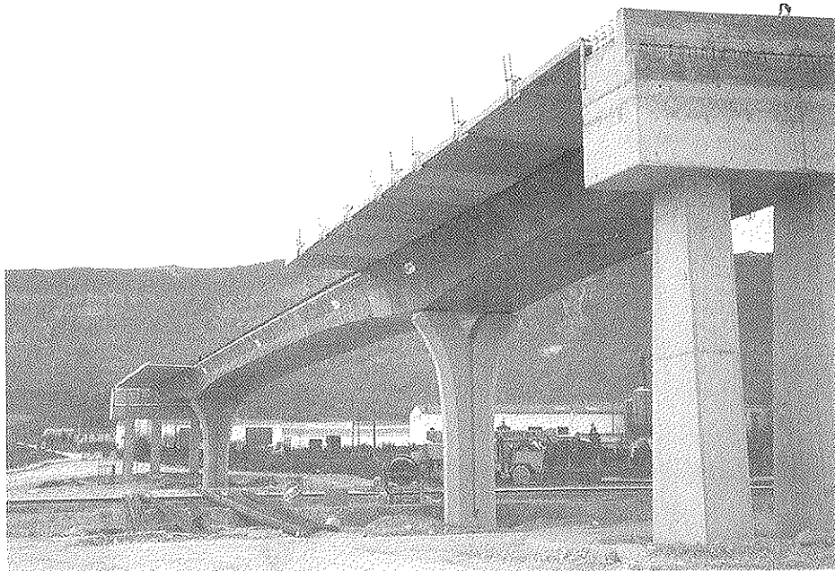
Foto 23. Paso superior en Autovía Pamplona-Vitoria. Prefabricación de pilas, viga parabólica continua y prelosas del tablero. Luces: 18 - 42 - 28 m.
