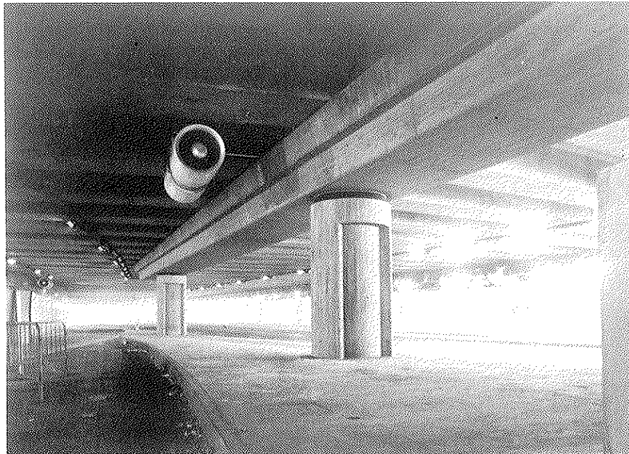
Fig. 3. Vista de la viga interior de apoyo de las vigas de la bifurcación.
