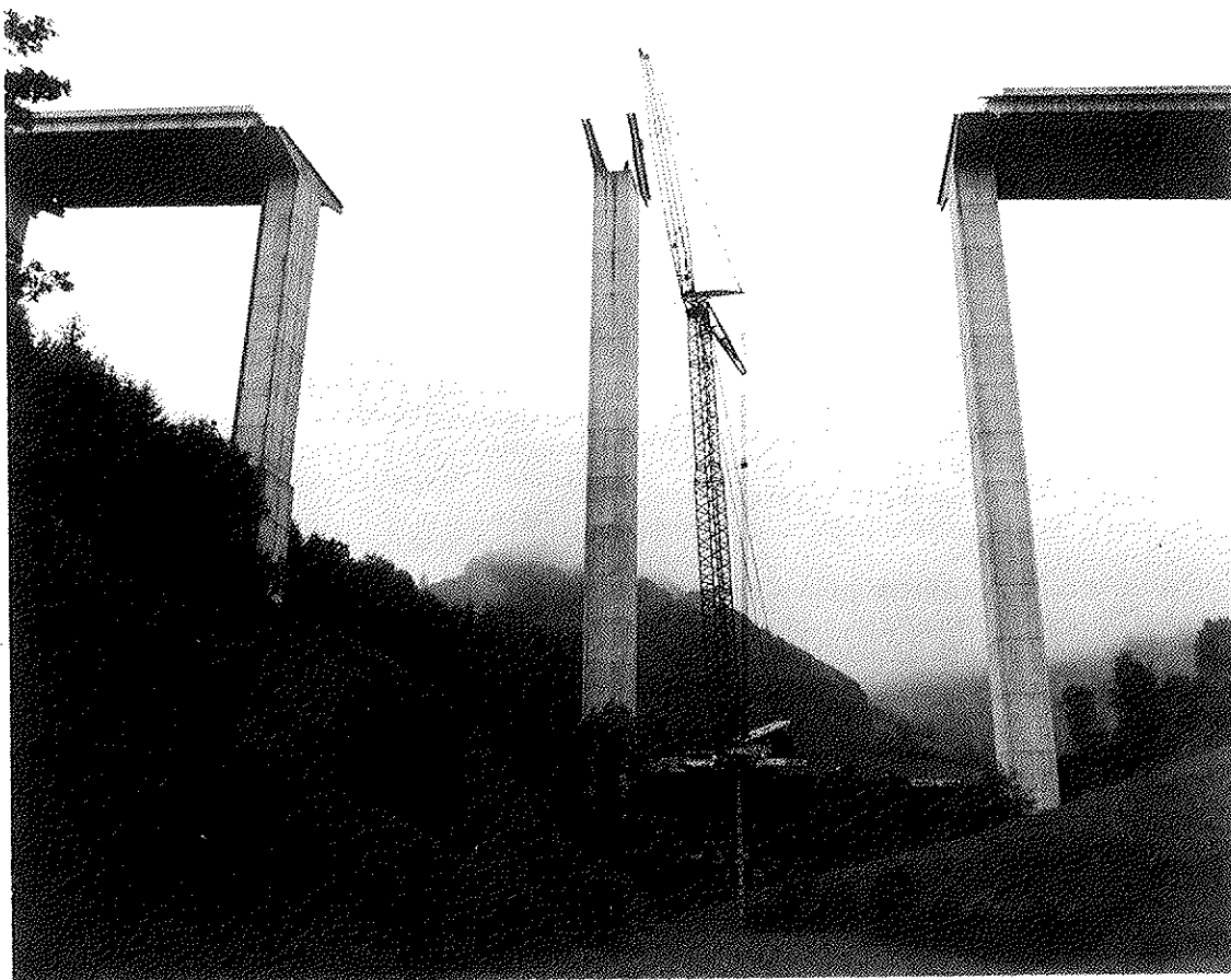
Fig. 2. Viaducto de Areso en Autovía Navarra-Guipúzcoa. Montaje de dinteles prefabricados de 22 m de longitud y 75 toneladas de peso, altura de pila 92 m. Grúa LTH - 1.800 con pluma de 116 m.
