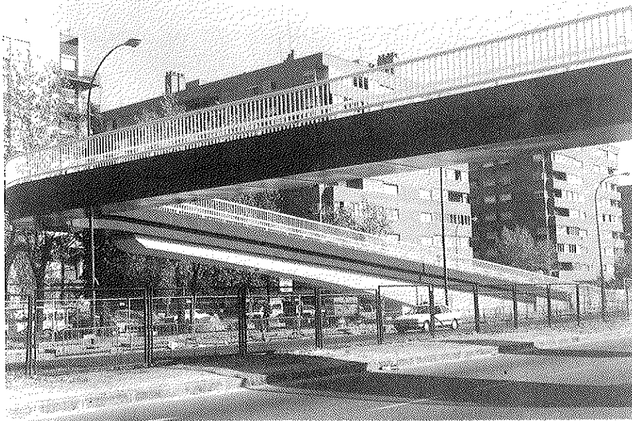
Fig. 8. Vista lateral de la pasarela.
