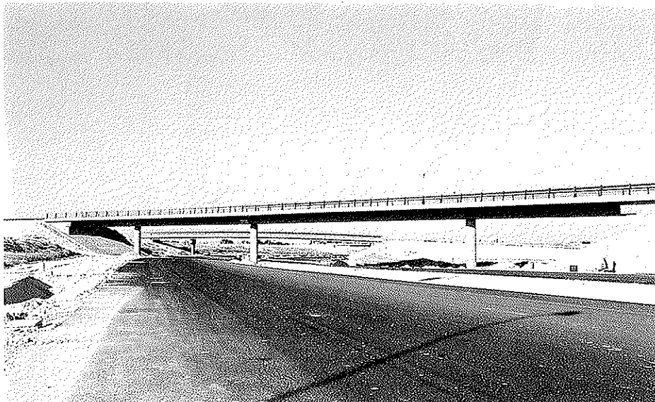
Fig. 8. Vista general de la E-1.
