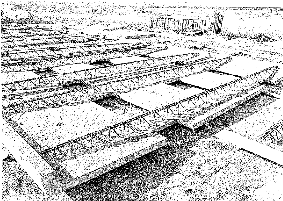
Fig. 13. Prelosas prefabricadas de la E-6.
