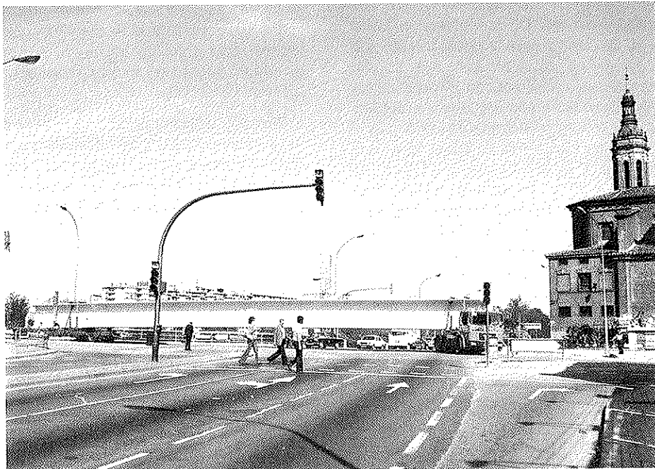
Foto 5. Transporte de vigas de 2 m de canto y 40 m de longitud con destino a un puente sobre el río Ebro, ejecutado en 1973.
