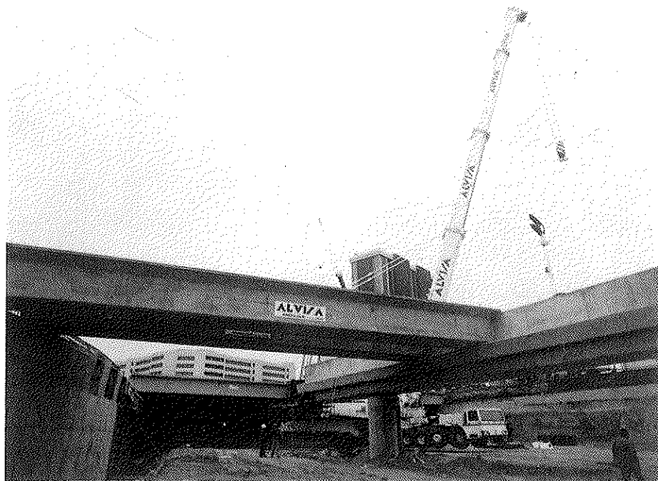
Fig. 4. Montaje de las vigas prefabricadas sobre la viga de apoyo.
