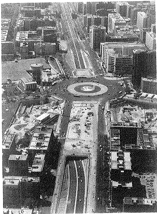
Fig. 2. Vista aérea del paso inferior.
