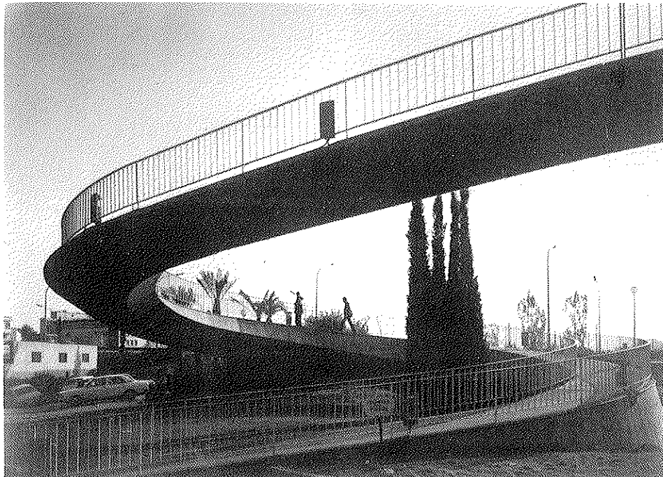
Fig. 3. Vista del caracol lateral de la primera pasarela.
