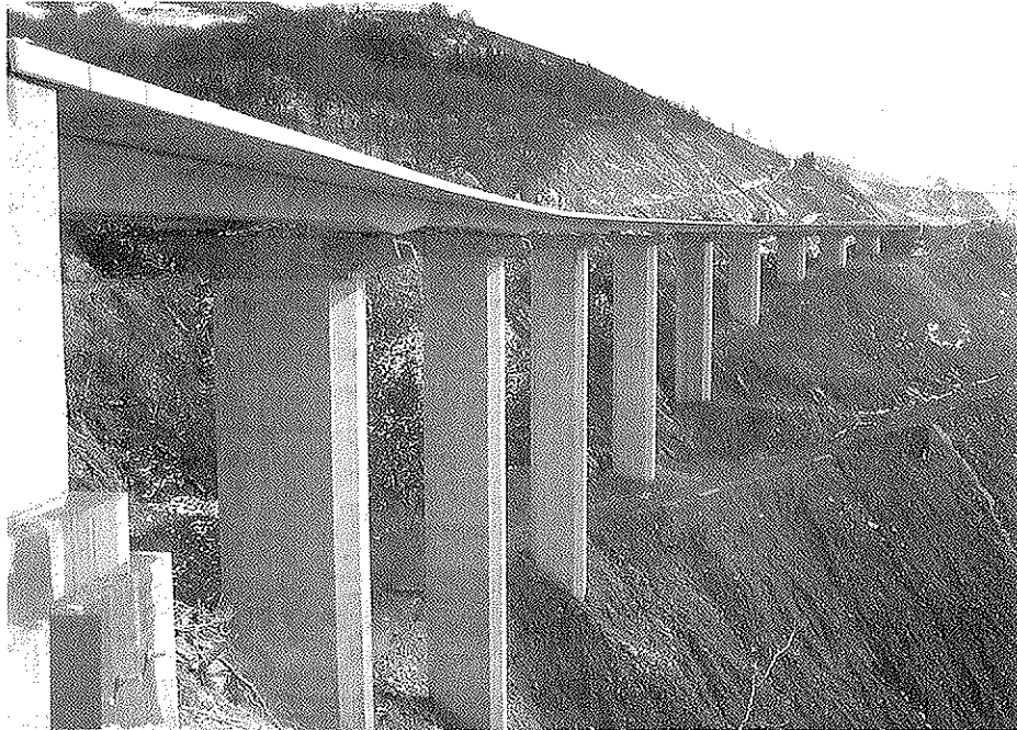
Foto 27. Viaducto de San Lorenzo en la Autovía de Navarra-Guipúzcoa: Cinco tramos de 50 m de luz formando un tablero continuo hiperestático bicelular de canto variable con plataforma de 21,50 m de anchura. Se completa con otros cinco tramos de 38 m de luz, isostáticos.
