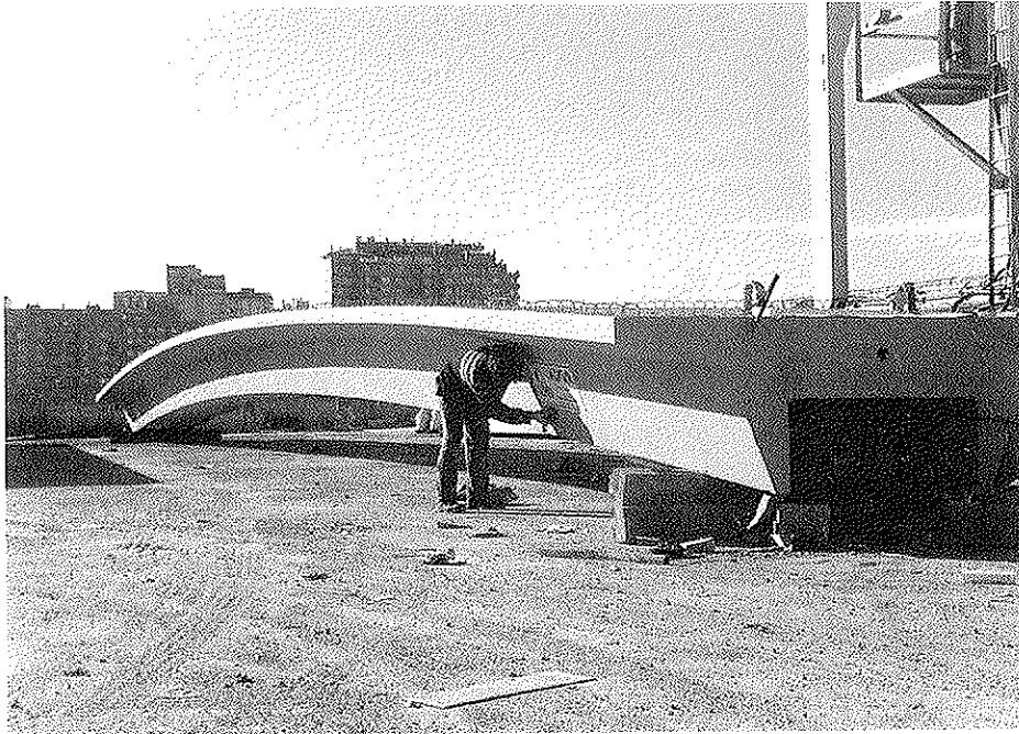
Foto 13. Viga-cajón cerrada y directriz curva para pasarela peatonal en Zaragoza. Longitud de la viga: 34,36 m.
