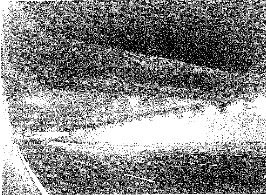
Fig. 6. Vista de la embocadura sur desde el exterior del paso.
