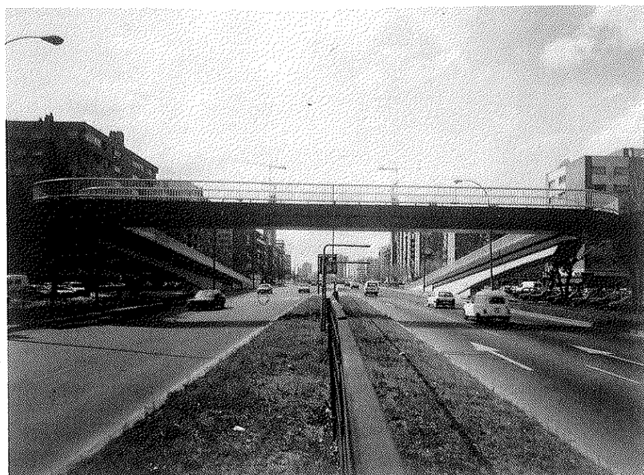
Fig. 9. Vista frontal de la pasarela.
