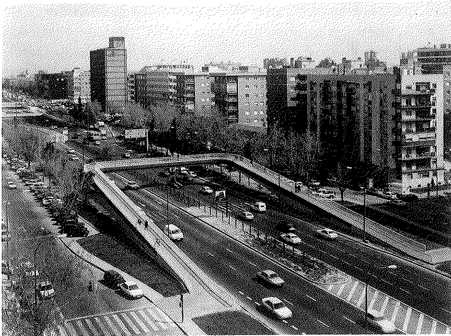
Fig. 7. Vista aérea de la pasarela.
