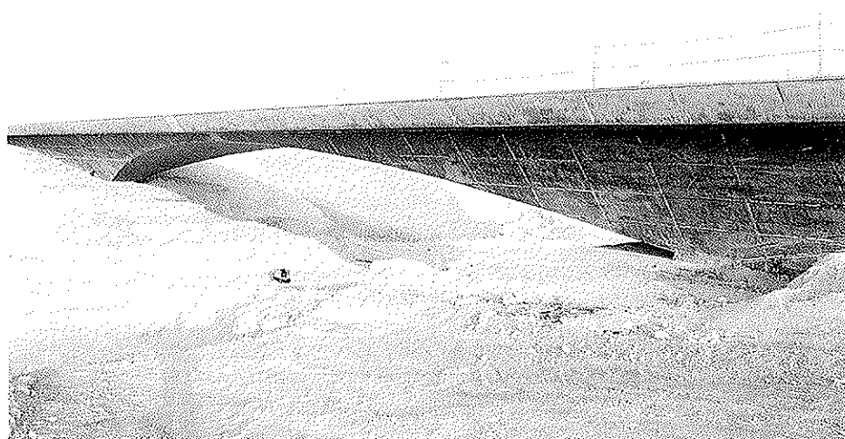
Fig. 4. Vista lateral de uno de los pasos.
