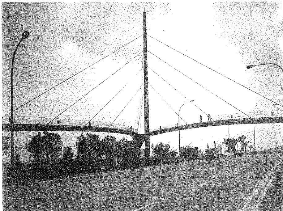
Fig. 4. Vista general de la pasarela en su primera posición.
