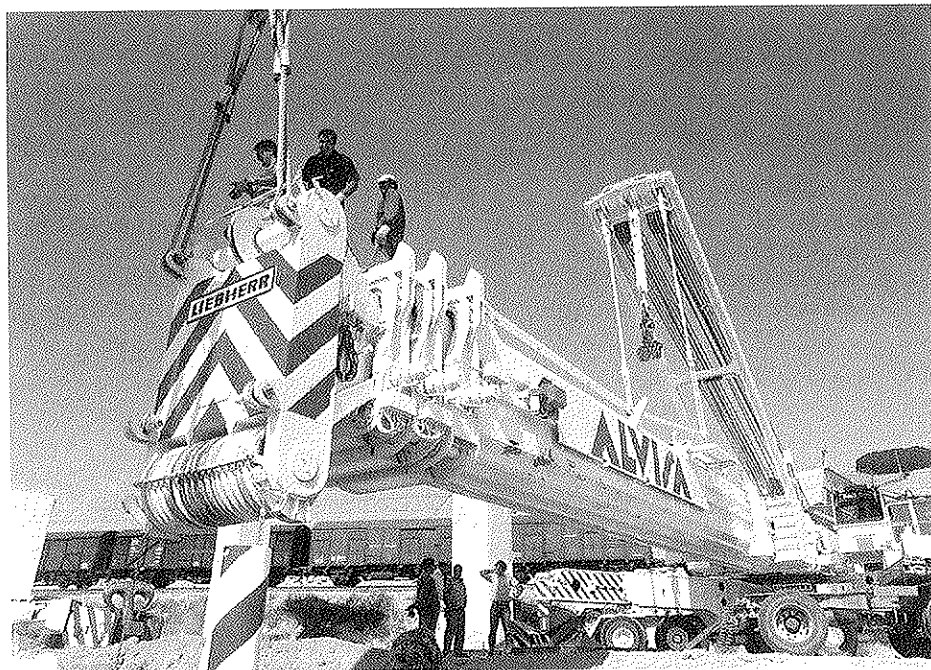
Foto 10. Grúa automóvil de 800 t de capacidad de carga.
