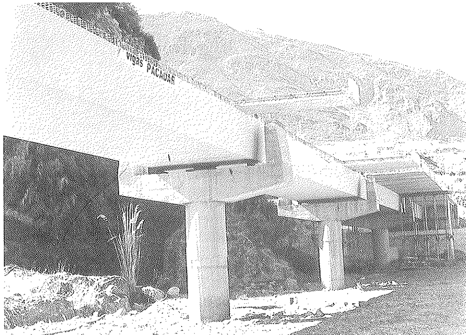
Figura 3. Nuevo tablero continuo prefabricado por PACADAR, sobre pilas antiguas.
