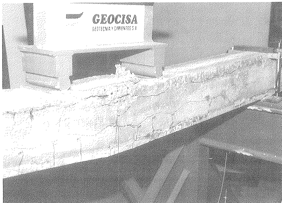
Figura 9. Rotura a flexión por aplastamiento del hormigón (tipo 2).
