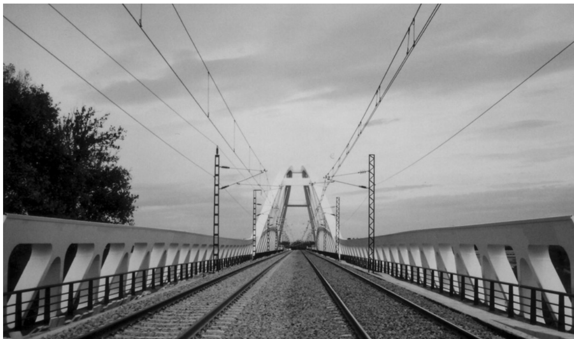
Figura 5. Vista del puente desde la plataforma.
