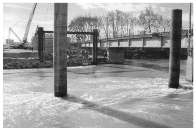
Figura 8. Apoyos provisionales para el vano central.
