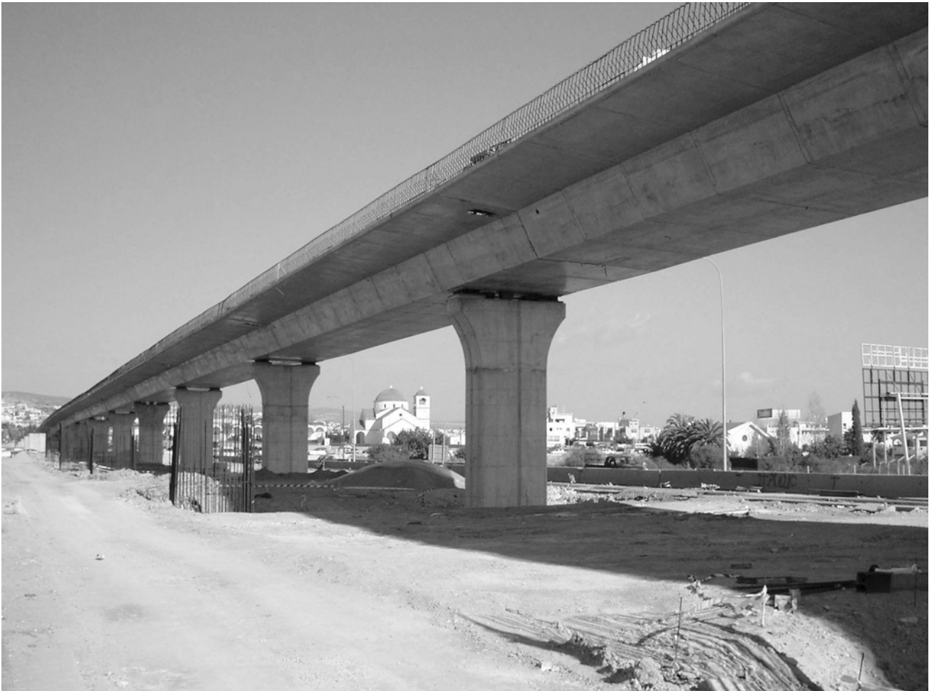
Figura 1. Viaducto de Limassol, en construcción.
