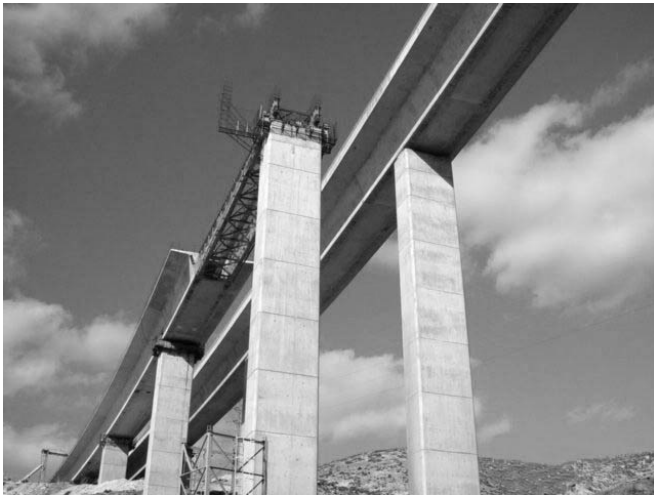
Figura 18. Tablero en proceso de empuje.
