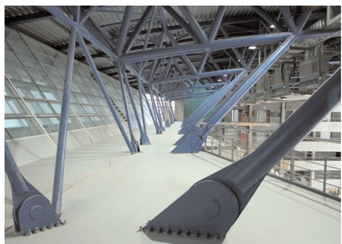
Figuras 16 y 17. Detalle de apoyo de las vigas longitudinales en el lado Goya. Figures 16 and 17. Detail of the connection between longitudinal roof beams and concrete pilaster on Goya side.
