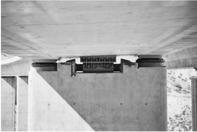
Figura 20. Amortiguador transversal en cabeza de pila.
