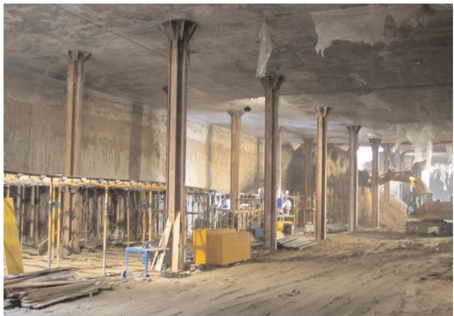
Figura 19. Construcción de sótanos. Figure 19. Basement construction.
