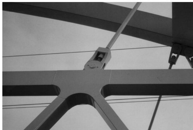
Figura 11. Detalle de las péndolas.
