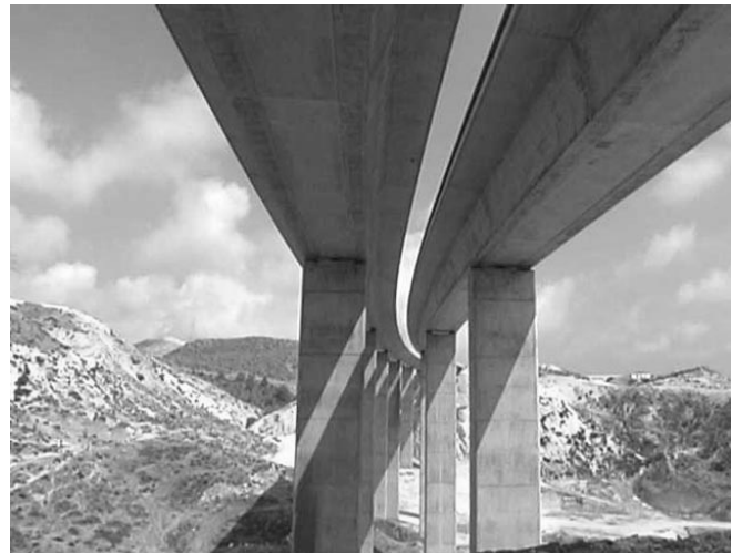
Figura 16. Viaducto Petra Tou Romiou.
