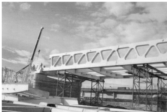
Figura 7. Montaje del vano cuatro.
