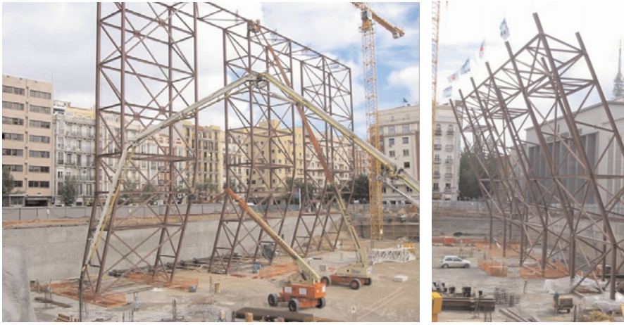
Figuras 20 y 21. Estructura metálica de pilares. Figures 20 and 21. Pilasters steel skeleton.
