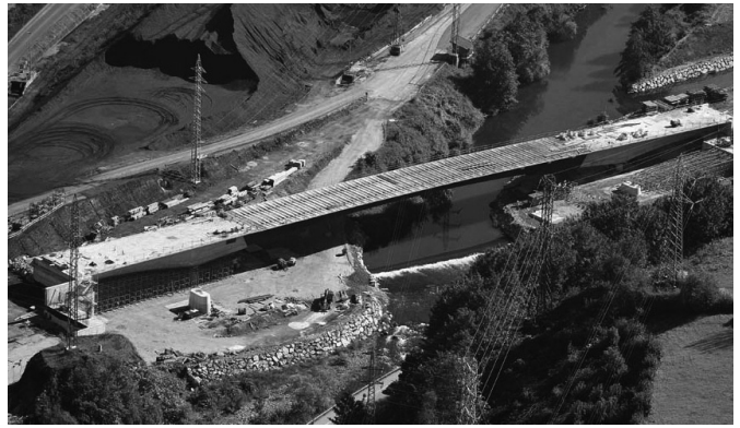
Figura 24. Vista aérea del primer viaducto con todas las prelosas ya colocadas.
