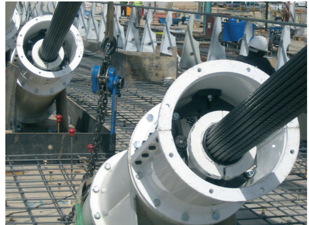
Figura 34. Amortiguador ya montado. Figure 34. Damper on site.
