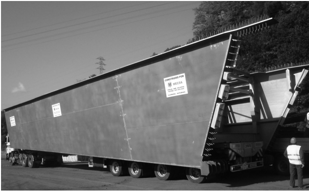
Figura 13. Transporte del primer tramo metálico.
