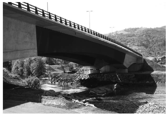
Figura 28. Vista inferior de los dos viaductos concluidos.
