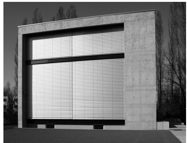
Figura 27. Vivienda terminada con persianas.
