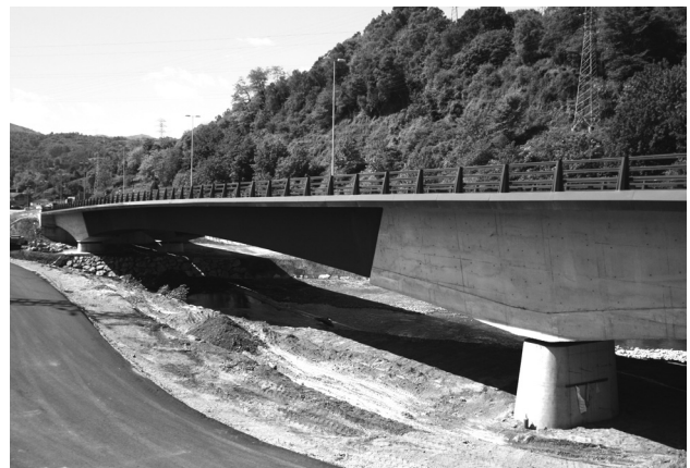
Figura 29. Vista lateral de los dos viaductos concluidos.
