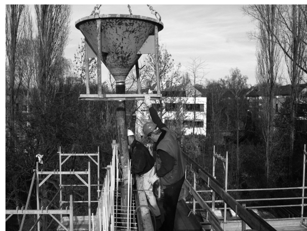
Figura 18. Hormigonado con cuba y tubería.
