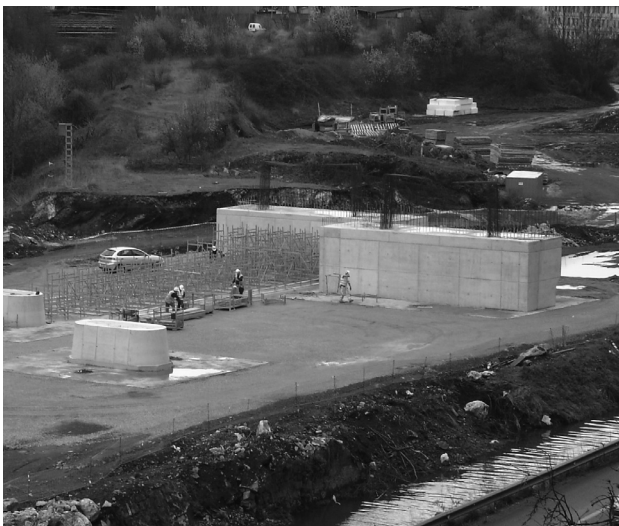
Figura 11. Vista de las pilas y la primera fase de estribos ejecutada e inicios de colocación de la cimbra del cajón de hormigón.
