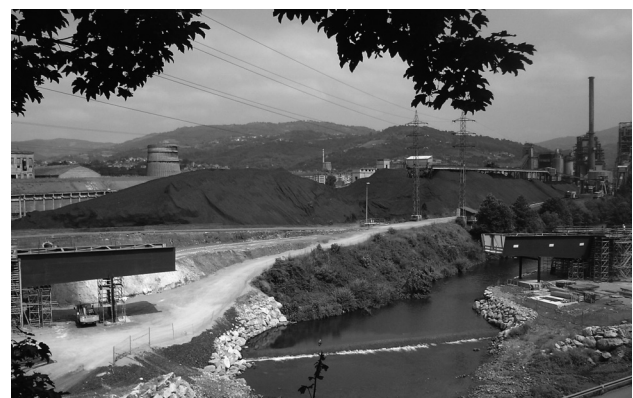
Figura 15. Vista de los 2 tramos laterales metálicos apeados.
