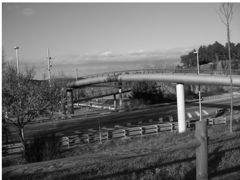
Figura 2. Vista de conjunto de la pasarela de La Triola.
