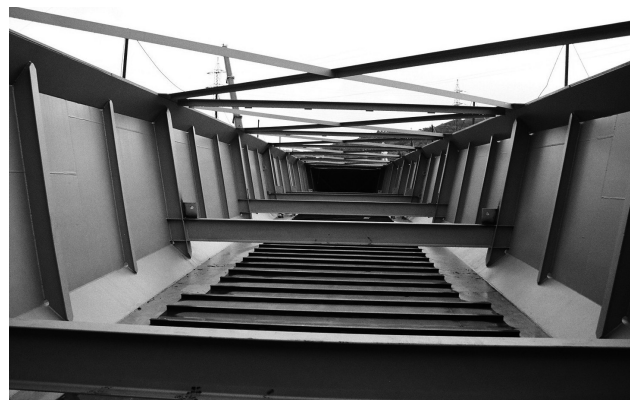
Figura 22. Vista interior del centro de vano.
