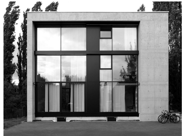
Figura 26. Vivienda terminada, fachada sur.
