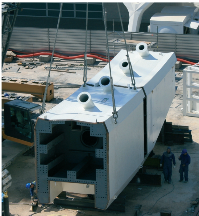
Figura 25. Dovela de pilono. Figure 25. Pylon erection unit.
