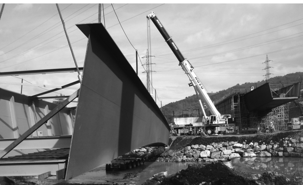
Figura 19. Izado del tramo central metálico.
