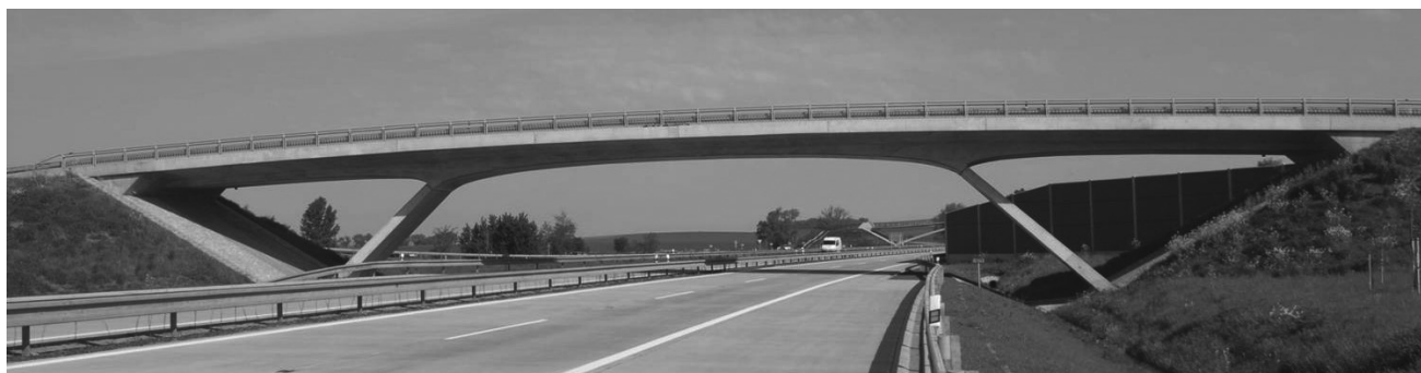
Paso superior de autovía proyectado por Strasky, Husty and Partner.
