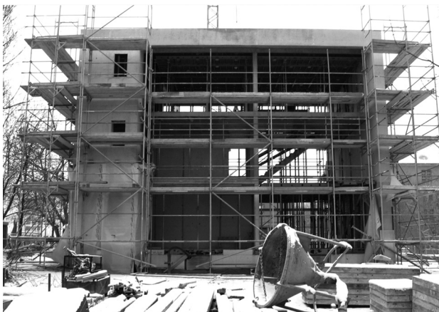
Figura 24. Fachada norte en construcción.
