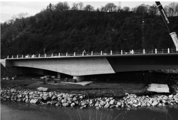
Figura 5. Vista de uno de los vanos laterales de hormigón con 27,5 m de luz.
