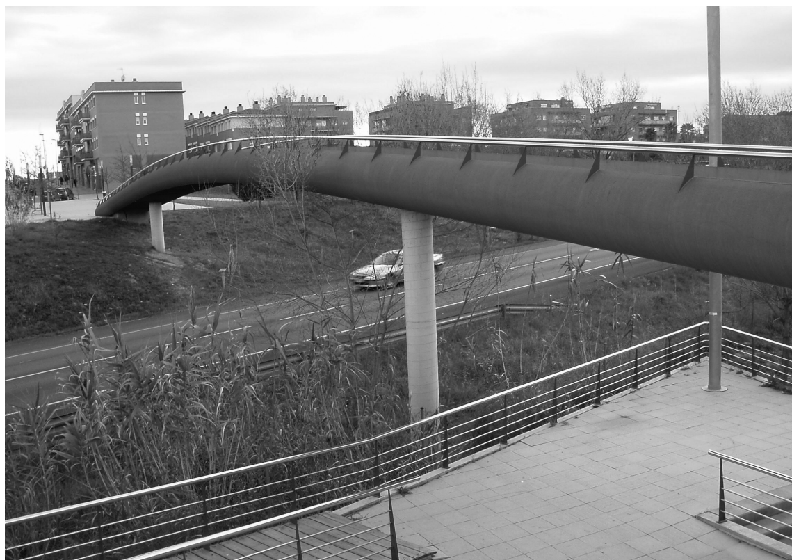
Figura 1. Vista lateral de la pasarela del Gat Cendrer.
