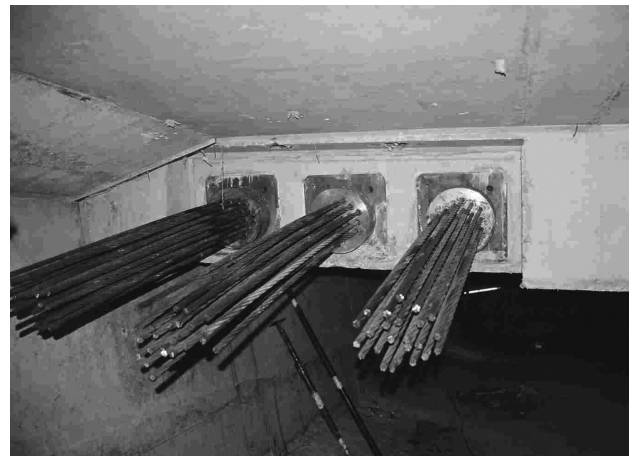
Figura 7. Vista de anclajes de pretensado en cuñas
