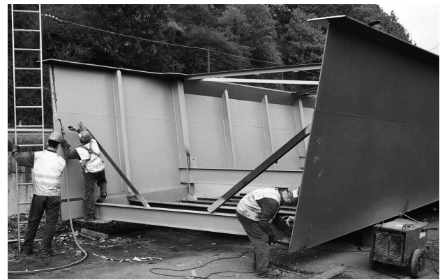
Figura 20. Corte de demasías en el tramo central.
