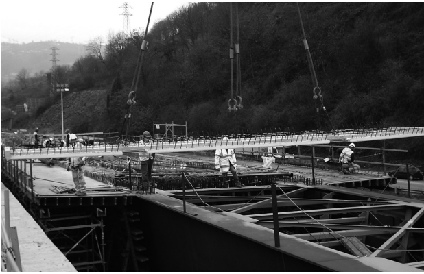
Figura 23. Colocación de prelosas prefabricadas.
