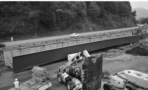
Figura 18. Vista del tramo metálico central de 50 m preparado para su colocación.
