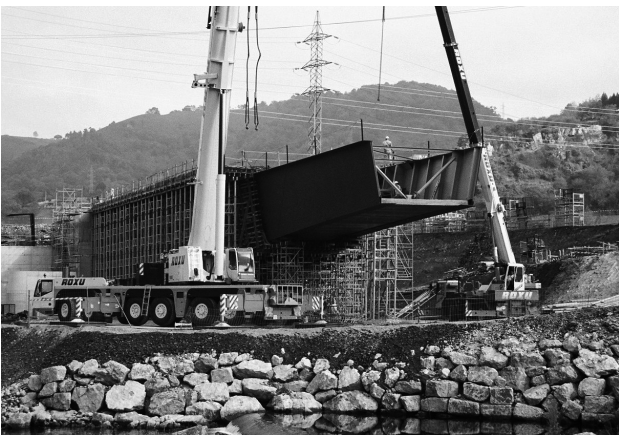
Figura 17. Vista del voladizo pretensado y desapeado.
